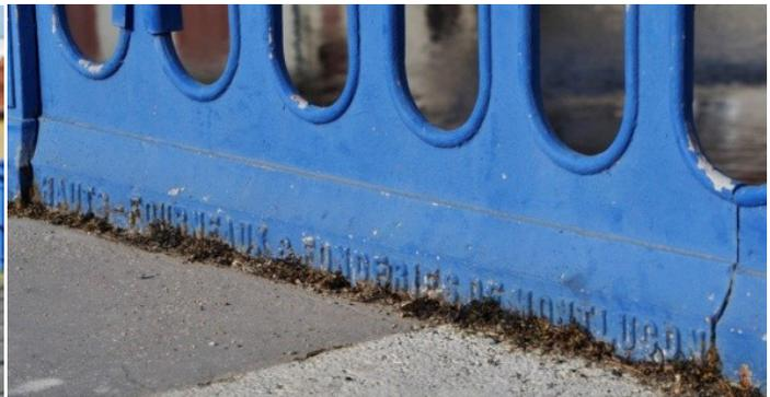
parapet du pont en fonte coulée à Montluçon
